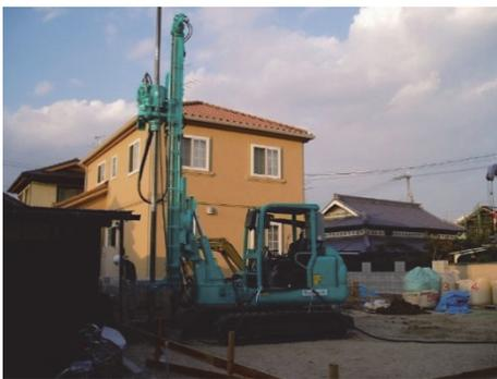
図6 宅盤改良工事
