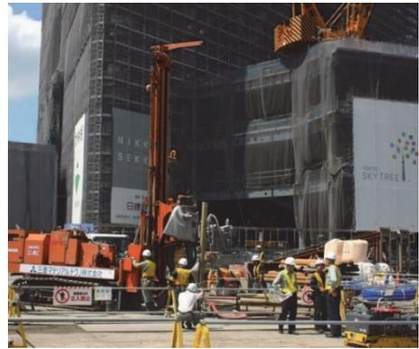
図8 東京スカイツリー地区 熱供給事業でのソニックドリルでの採熱孔掘削 [写真提供：株式会社東武エネルギーマネジメント]
