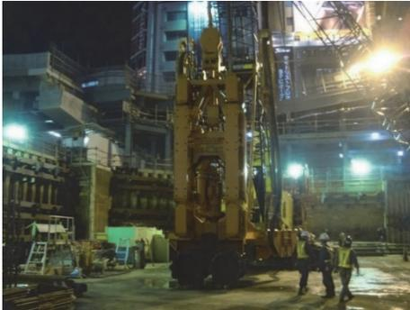
図4 地中連続壁工事
