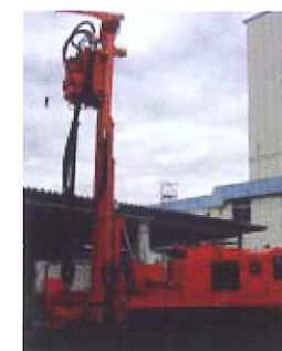
井戸改修工事
