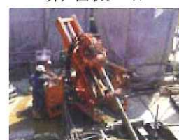
アンカー工事
