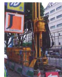
地中熱採熱孔掘削
