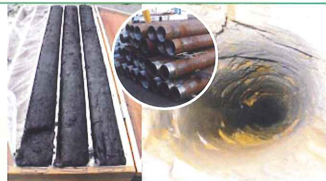
「左：サンプル採取例」「中央：10-3/4"ドリルロッド」「右：岩盤掘削状況」
