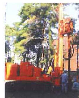
土壌汚染対策工事
