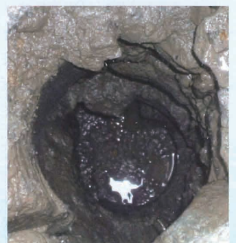
礫・玉石掘削状況
