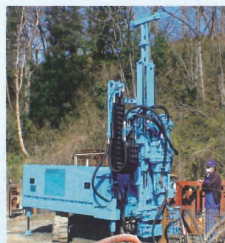
SP-8000現場掘削状況
