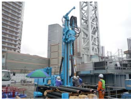
地源热泵孔施工
