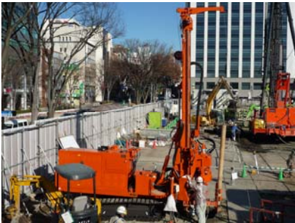
地源热泵孔施工
