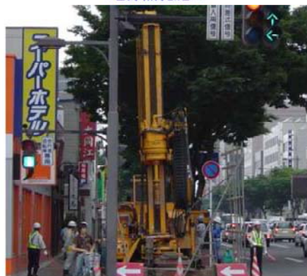
地源热孔施工
