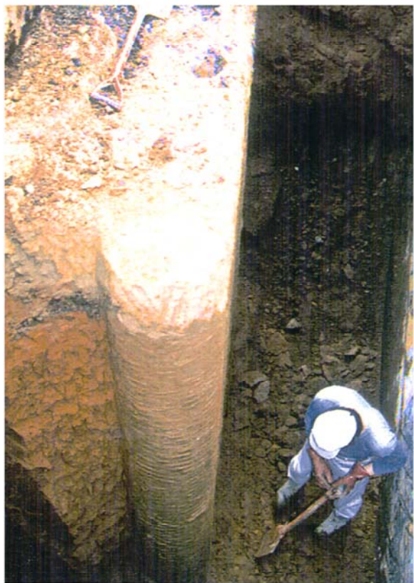
改良体开挖工作
