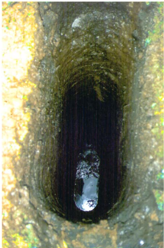
挖完改良体后的基坑
