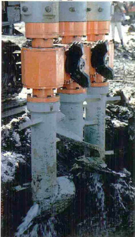
上左：钻头 上右：作业状态（动力头） 中左：施工直规 中间：水泥浆喷射状况 下左：改良体 下右：挖出后的改良体
