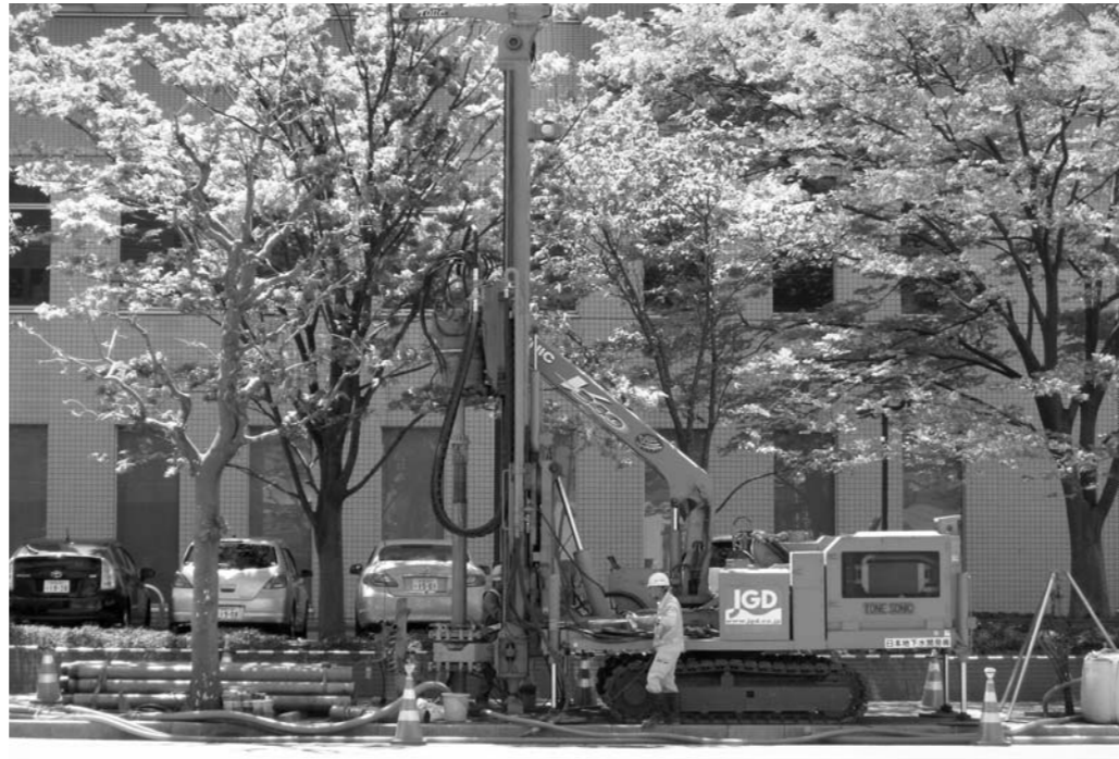
地中熱交換井を掘削する「SD-150」(提供:日本地下水開発)
