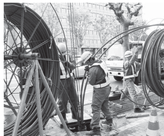
採熱用Uチューブ挿入風景
