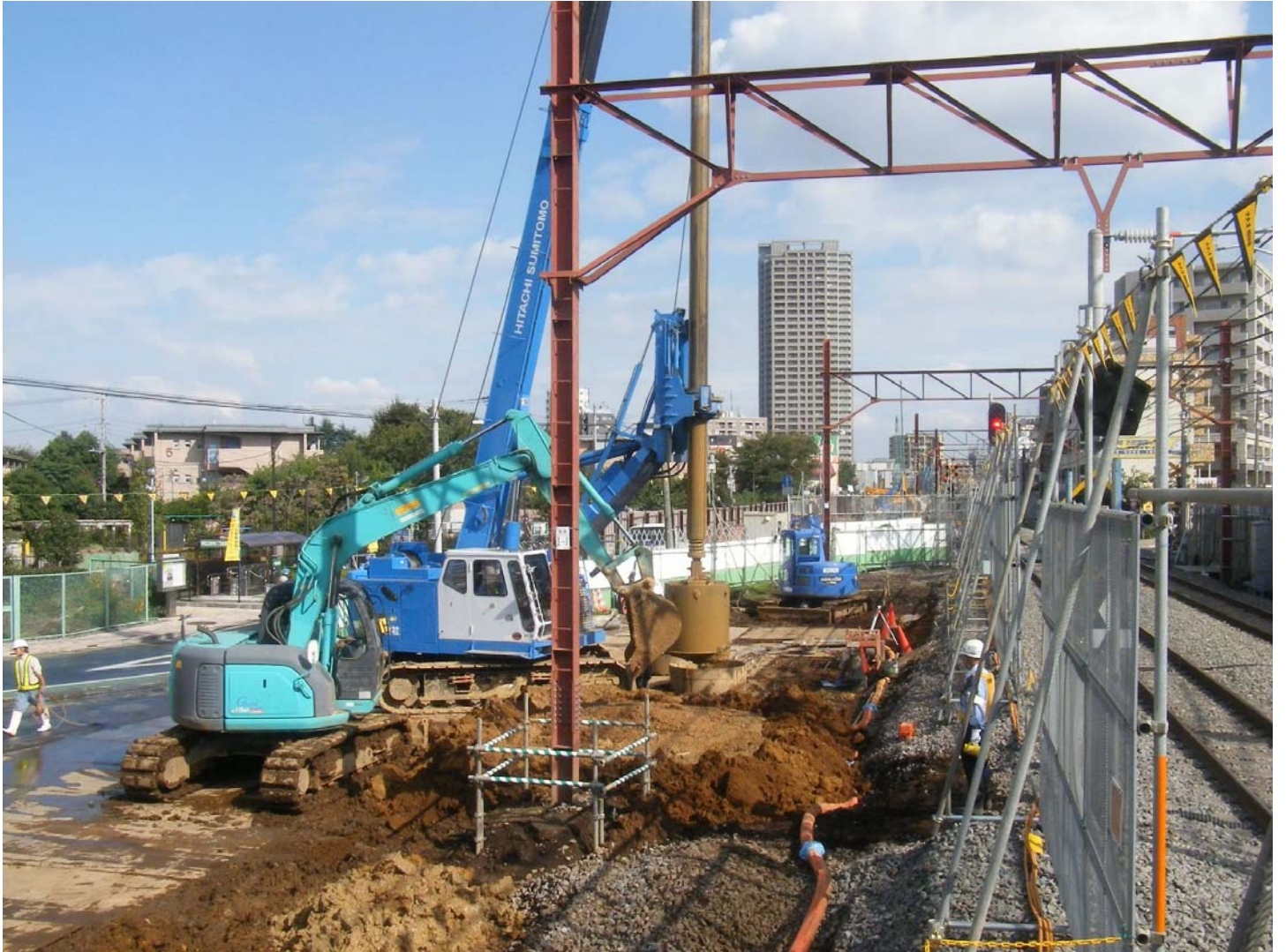
アースドリル工法 鉄道近接の施工風景
