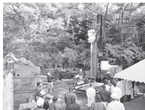
写真-3 自動掘削テスト状況 (2016.10.28)
