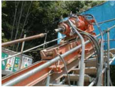
水平調査掘削
